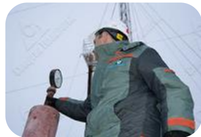
Ремонтно- изоляционные работы
